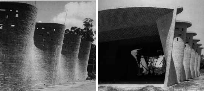
Eladio Dieste 的Atlantida Church紅磚教堂營建過程，此作品突破磚造的空間形式。（出處：Eladio Dieste：1943-1996）
